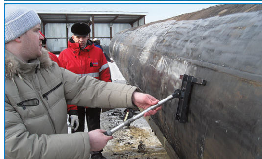
Рис. 4. Опытно-промышленные испытания ДНШ-24 в ООО «Газпром трансгаз Югорск»
