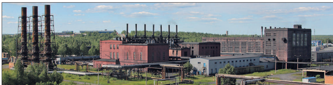
Рис. 1. Сосногорский ГПЗ. Цех по производству печного и термического технического углерода
