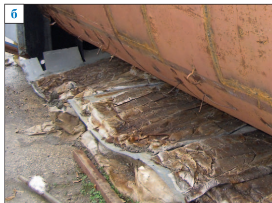
Рис. 1. Характерные нарушения теплоизоляционного покрытия корпуса подогревателя ПТПГ-30 с длительным сроком эксплуатации
