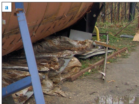
Рис. 1. Характерные нарушения теплоизоляционного покрытия корпуса подогревателя ПТПГ-30 с длительным сроком эксплуатации
